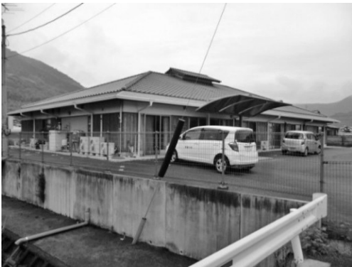
写真 4 生活介護事所「愛隣倶楽部」 (愛隣館より約 150m)
